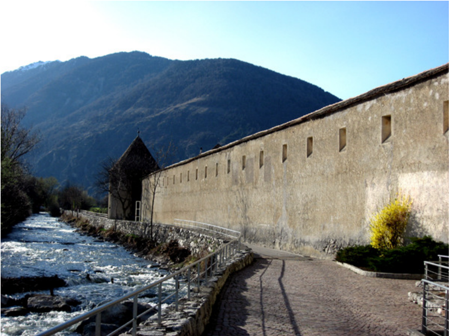
Eindrückliche südliche Stadtmauer an der Etsch
